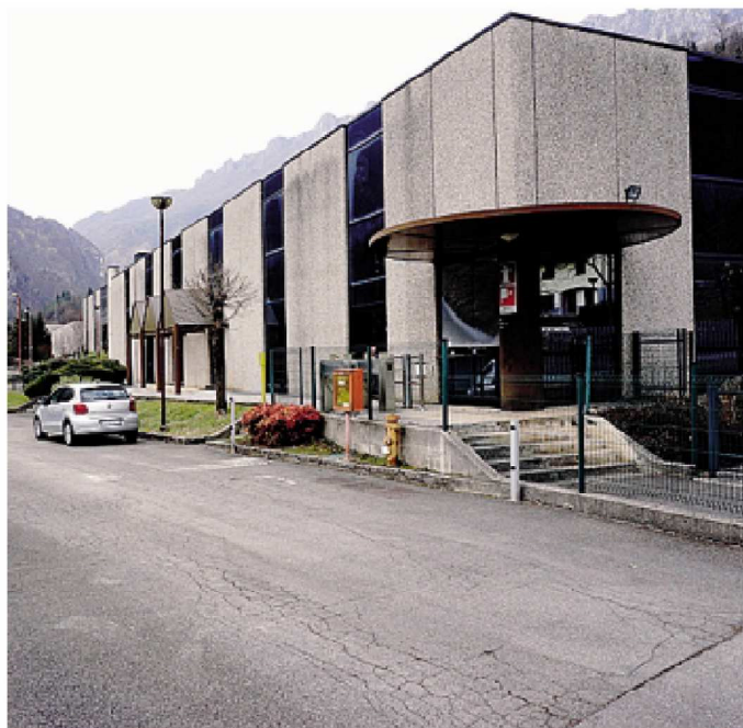
L'ex stabilimento Brembo in località Roncaglia
